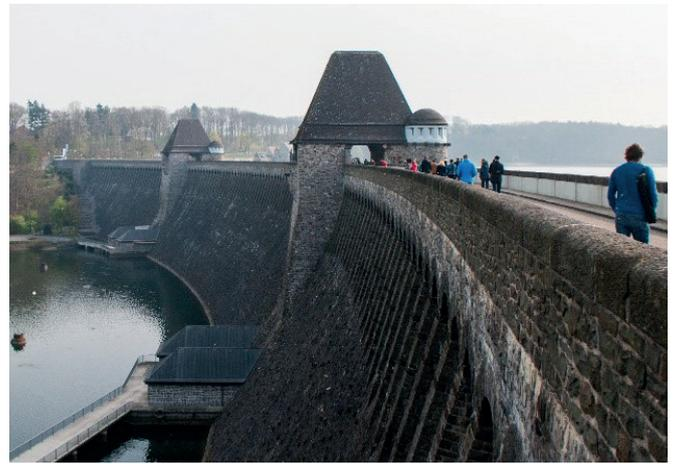
In den 1970er Jahren wurde die Talsperre umfassend saniert und ein Kontrollstollen in den Fuß der Mauer hineingesprengt. An der Mauerkrone befinden sich entlang der gesamten Mauer Überläufe, durch welche das Wasser treten kann, sobald die Maximalkapazität erreicht ist.
