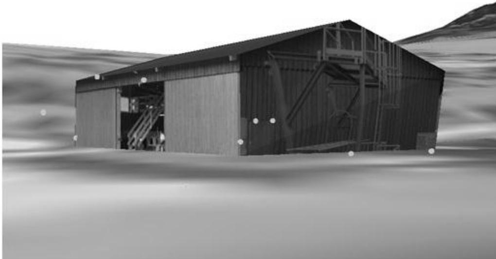
*Abb. 11: Passpunkte am EnBW-Gerätehaus*
