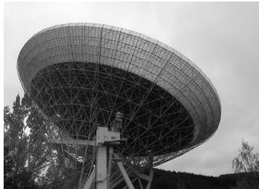
Das Radioteleskop Effelsberg wurde vor über 30 Jahren in einem kleinen Tal errichtet. Mit einem Durchmesser von 100m ist es eines der beiden größten vollbeweglichen Radioteleskope der Erde. Mit dem Teleskop lässt sich Radiostrahlung aus Millionen oder sogar Milliarden von Lichtjahren Entfernung messen und damit das Universum erforschen.
